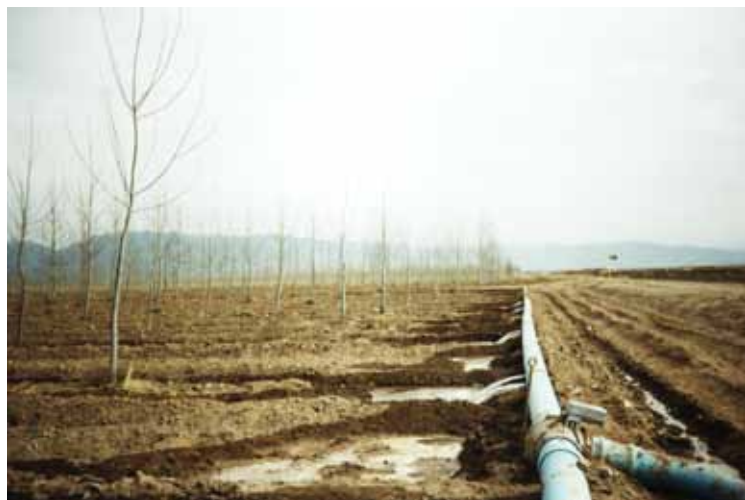
Figura 17 Riego por medio de tubos con aberturas móviles para regular el caudal. Plantación en San Juan.
