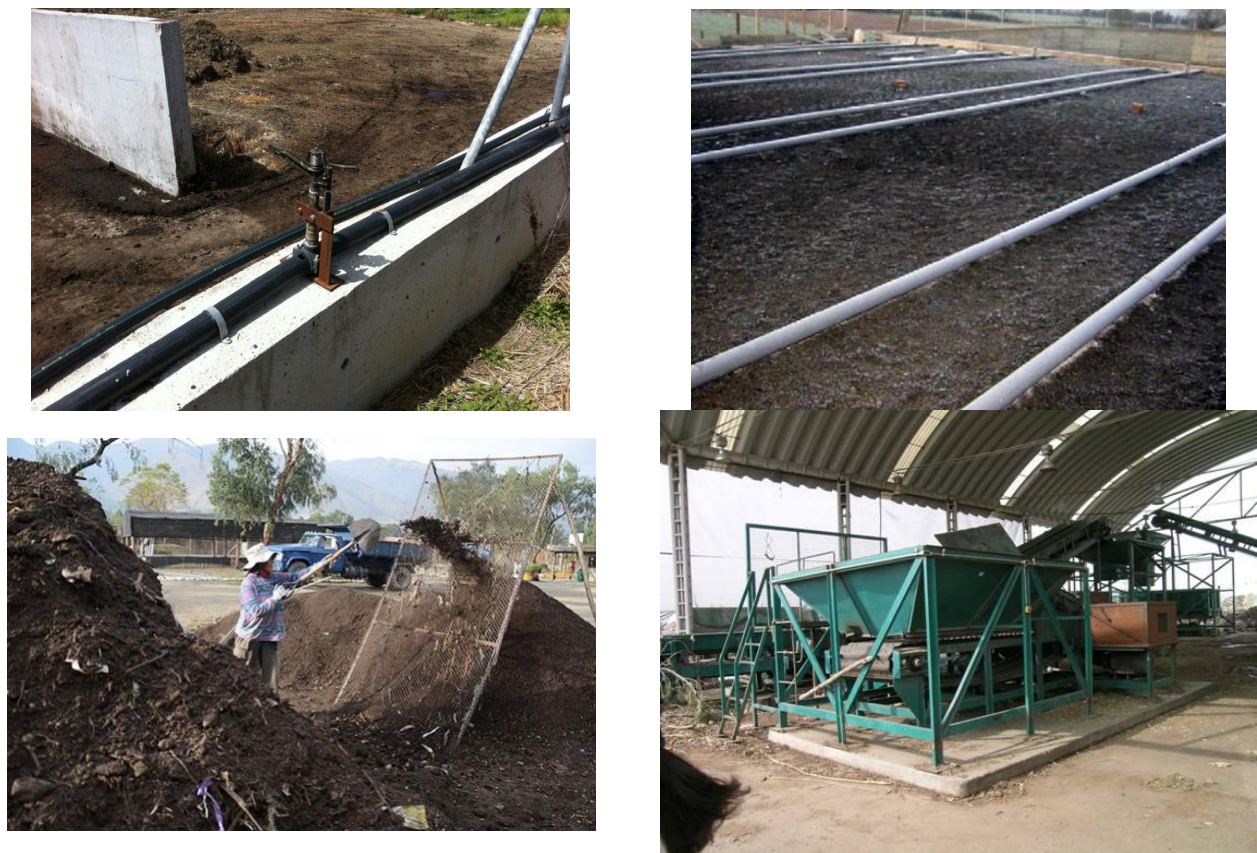
Foto 10. Riego por aspersion para enfriamiento de pilas (arriba izq.), sistema de camas (arriba der.), zaranda manual (abajo izq.) y mecánica (abajo der.) para la venta del lombricompost
