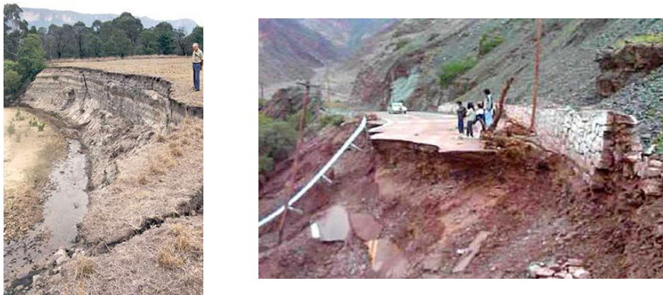
Figura 14. Manifestaciones de erosión por movimientos en masa
