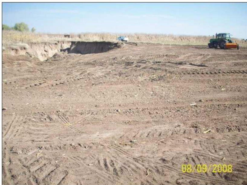
Figura 77. Parabolizado y albardonado de cárcava
