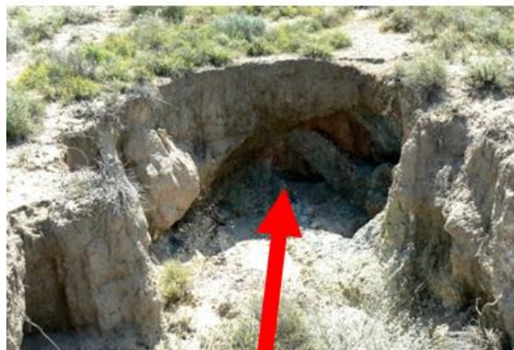
Figura 13. Vista de una cabecera de cárcava con proceso de debilitamiento y crecimiento en el sentido de la flecha
