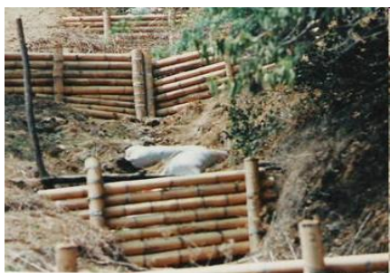
Figura 76. Rastrillos de retención para recuperación del piso de cárcava.
