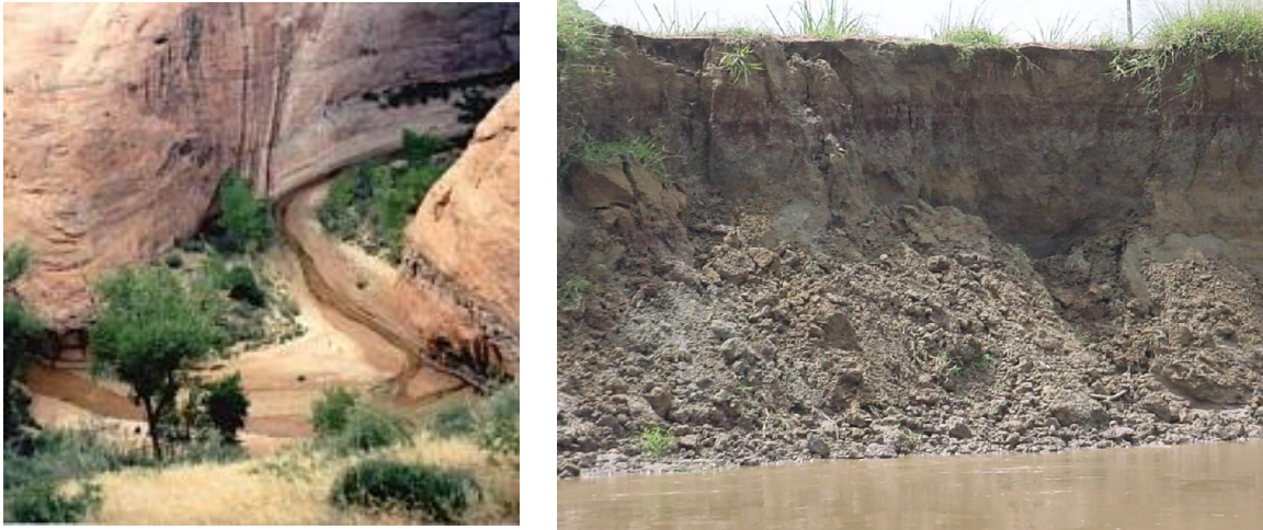
Figura 15. Erosión de margen de ríos
