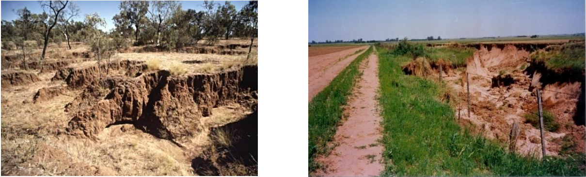
Figura 12. Manifestaciones de erosión en cárcavas
