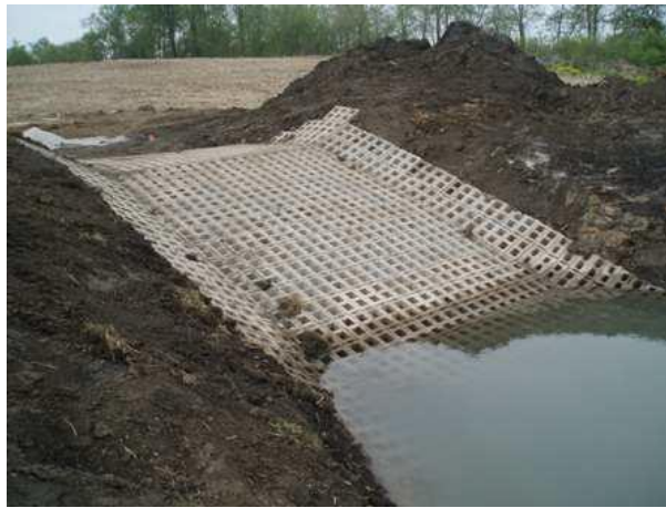
Figura 69. Tobogán de bloques para proteger la cabecera de una cárcava. ( www.prairiestateoutdoors.com )
