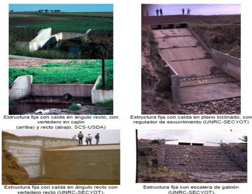
Figura 68. Estructuras para el control de cabeceras de cárcava.
