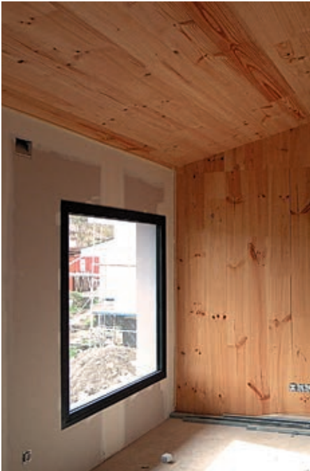
Foto 4. Acabados interiores vistos sin necesidad de trasdosado. Casa Odel. Estudio de arquitectura mycc.
