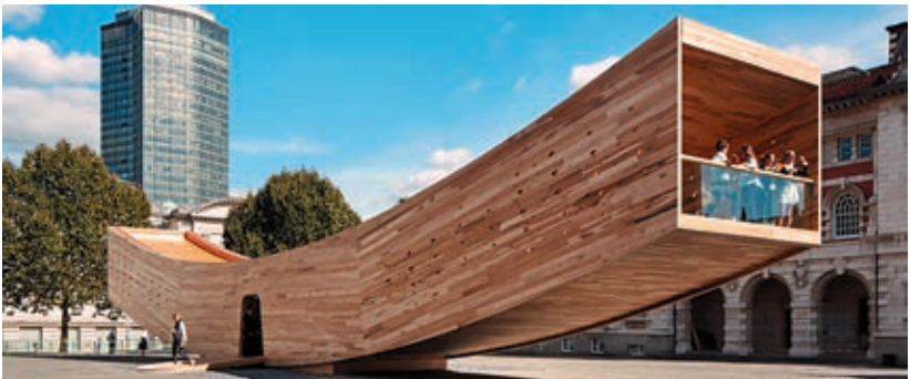
Foto. Alison Brooks Architects Ltd.
