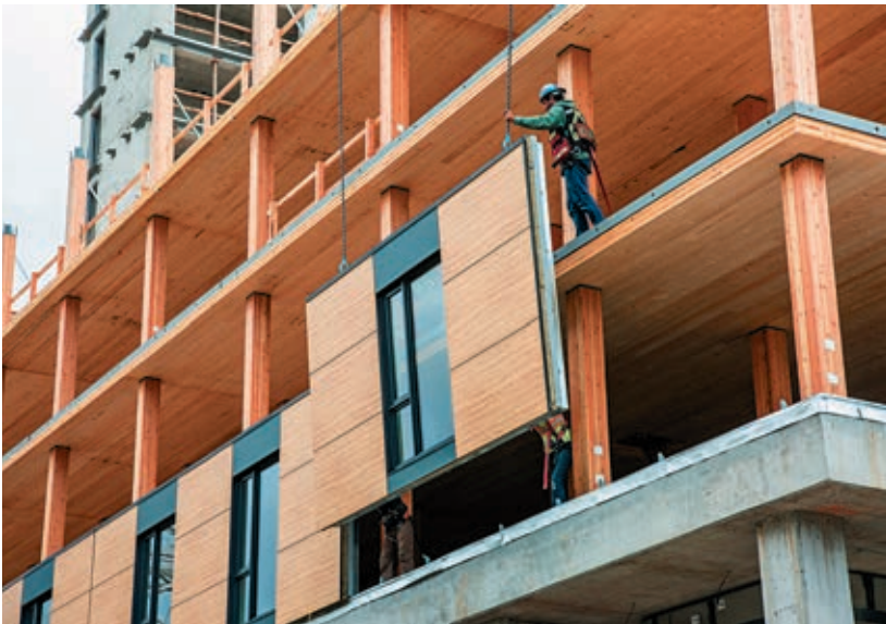
Foto 4. Paneles de estructura de acero y cerramiento de madera en el edificio Brock Commons Tallwood House de la Universidad de Columbia Británica (fotografía de K.K. Law, cortesía de Naturally Wood).
