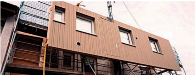
Foto 3. Módulo de fachada prefabricada en madera, con componentes constructivos y de instalaciones montados (4RinEU Project, Gump & Maier y Eurac Research, 2017).
