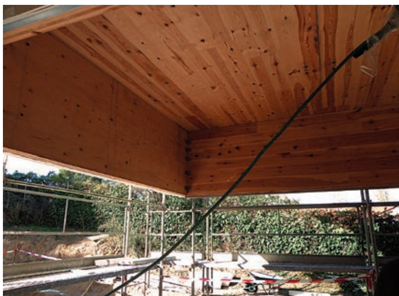
Foto 2. Casa Marbel. Estudio de arquitectura mycc.
