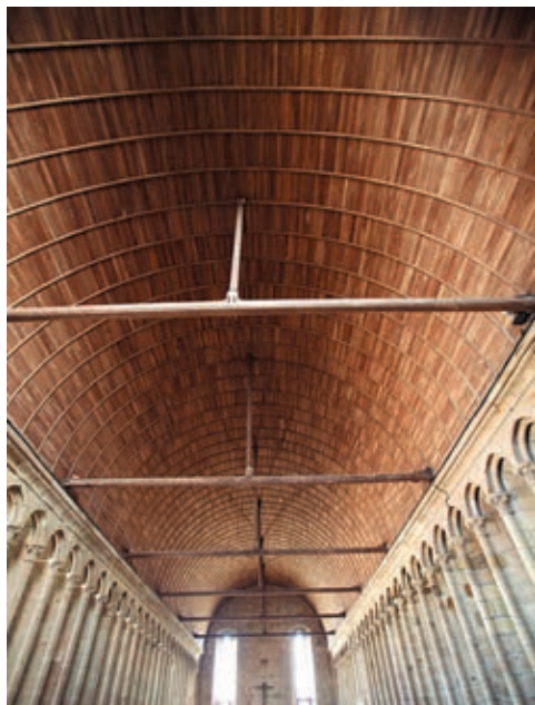
Foto 1. Estructura de grandes dimensiones y bajo consumo de material en madera. Michael Foley Photography 2013, Wooden Ceiling - Flickr(CC BY-NC-ND 2.0).
