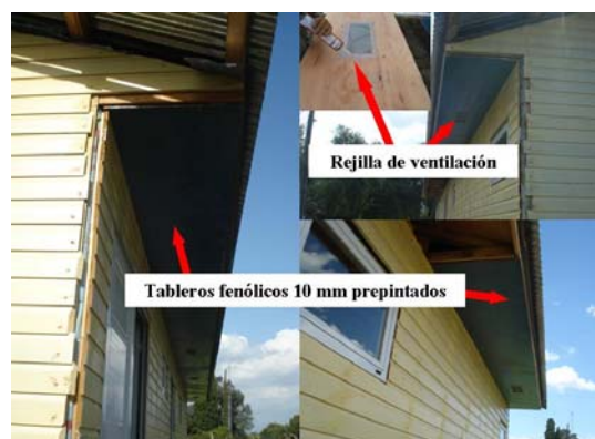
Figura 13. Aleros con ventilaciones de techo.
