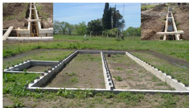
Figura 3. Fundaciones de hormigón armado. Figure 3. Concrete foundation.
