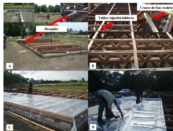
Figura 4. A. Colocación vigas reticuladas de madera-desagües; B. Cruces de San Andrés y “encuentros” Tableros fenólicos; C. D. Colocación-sellado-fijación polietileno de 200 \mu m .
