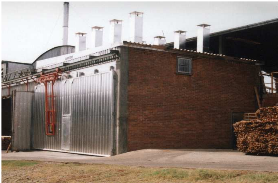
Secadero de mampostería con techo de aluminio
