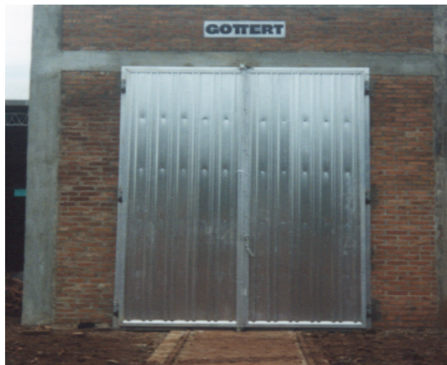
Secadero de mampostería
