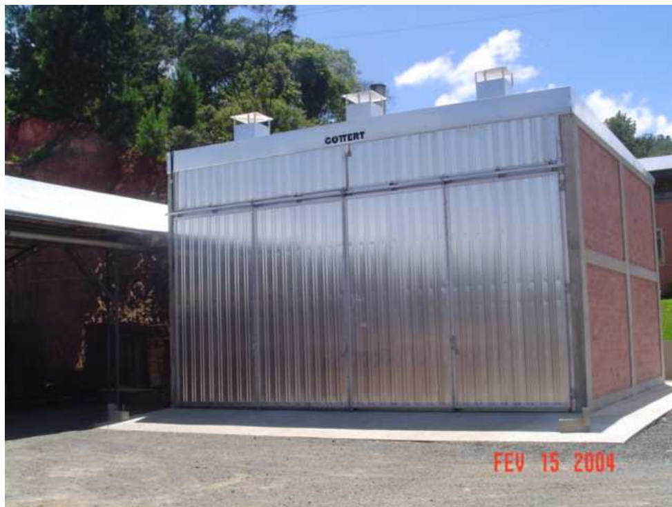
Secadero de mampostería con techo de aluminio
