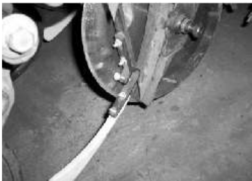
Figura 42. Fijación de la lengüeta en forma independiente del caño de bajada.
