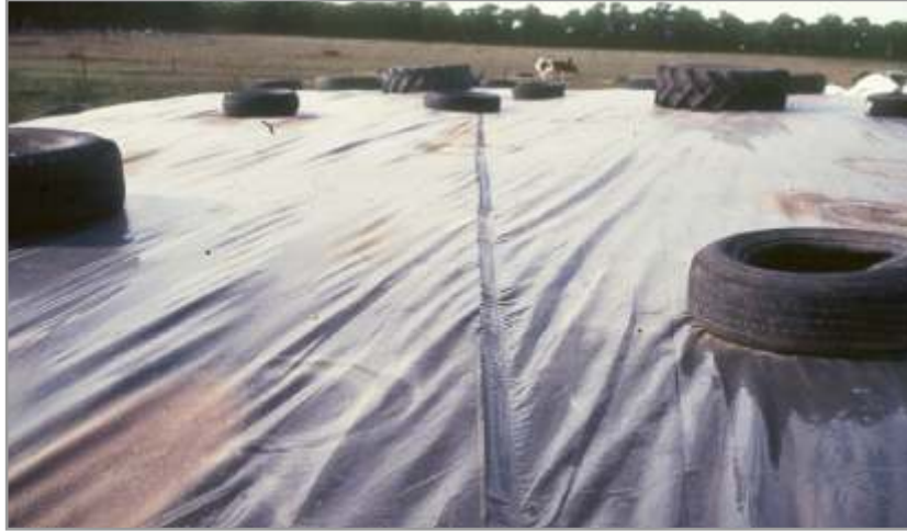
Figura 6.38. Correcta unión de las mantas plásticas de cobertura
