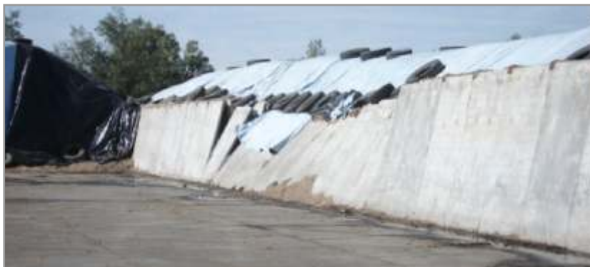
Figura 6.33. Cuando se utilizan estructuras de cemento es importante controlarlas periódicamente para corroborar que se hallan en buen estado.
