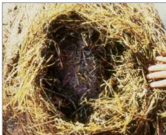
Figura 4.55. Rollo amarronado y con hongos en su interior, muestra del deterioro sufrido a causa del exceso de humedad.
