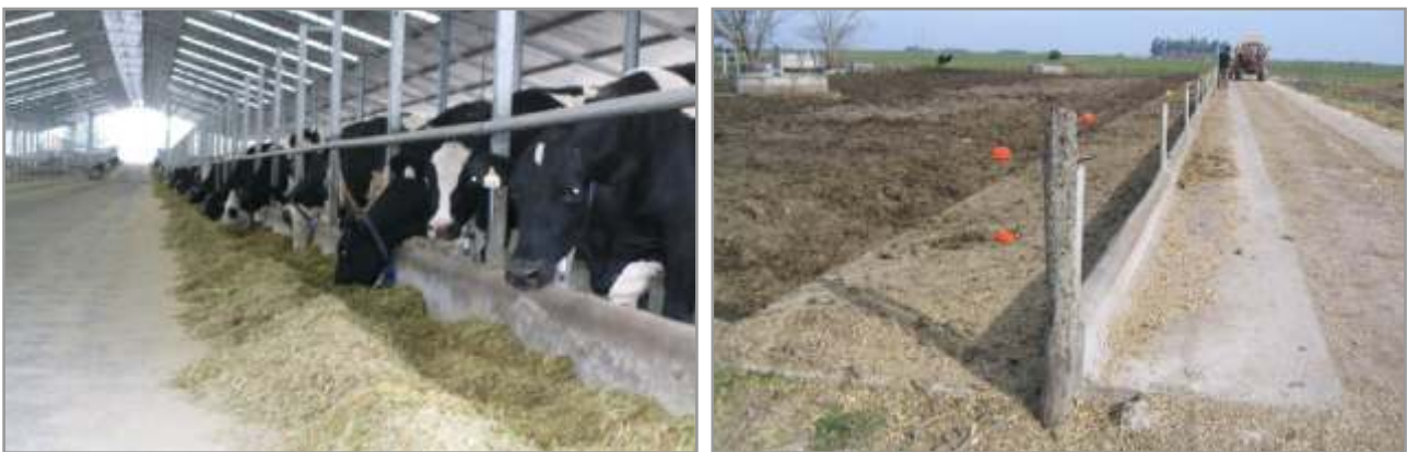
Figura 11.42. Planchada de suministro que resulta, económica, sencilla y eficiente para el suministro y la limpieza.
