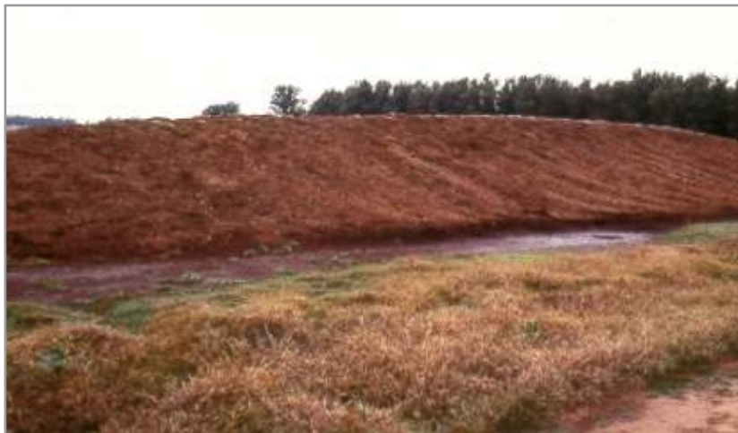
Figura 6.28. Sistema de drenaje en el lateral de un silo de grandes dimensiones.
