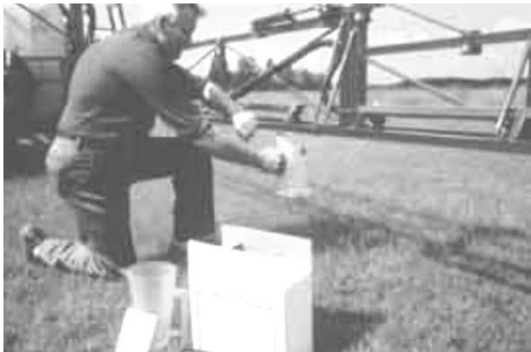
Figura 66. Evaluación del caudal erogado por las pastillas
