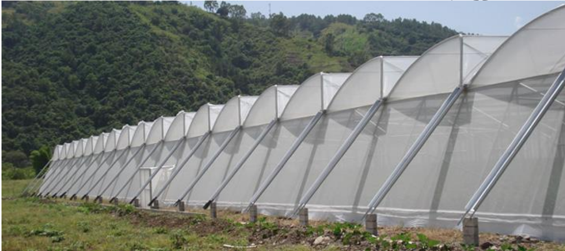
Invernaderos dientes de Sierra metálicos
