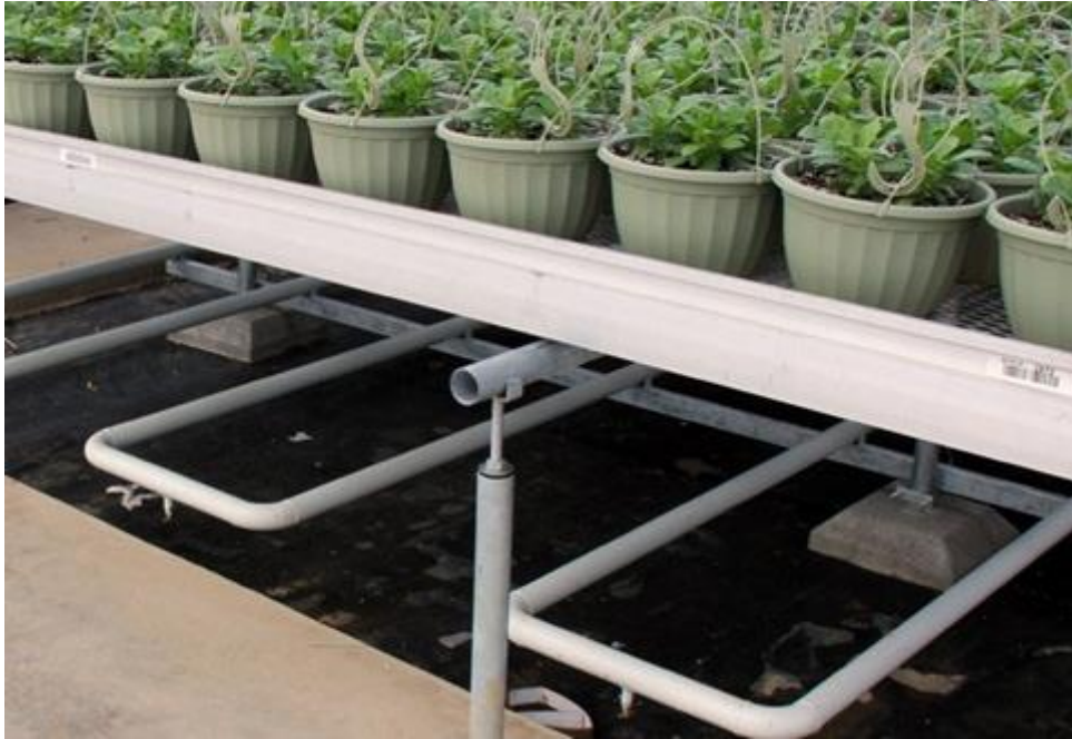
Calefacción del suelo para trabajo sobre mesadas en producción de plantas de interior. Holanda.
