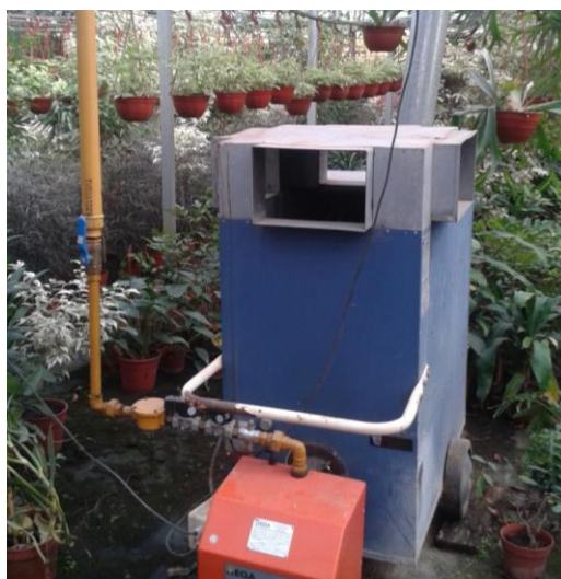
Salida de aire caliente para climatización de invernadero.
