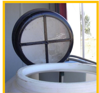
Fig. 6. Filtro en buen estado.
