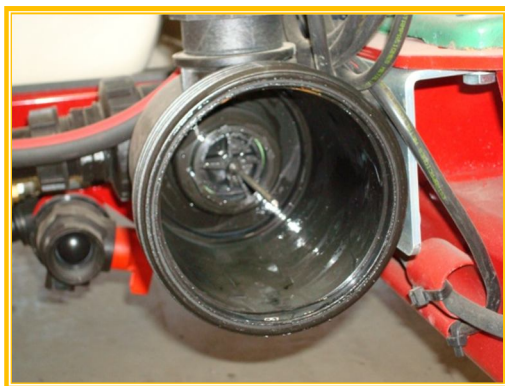
Fig.15. Dispositivo que no permite que se vacíe el depósito.
