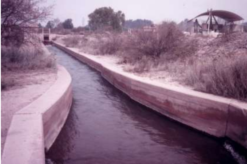
Aforador de resalto en Canal Playas, Valle de Ullum, San Juan, Argentina
