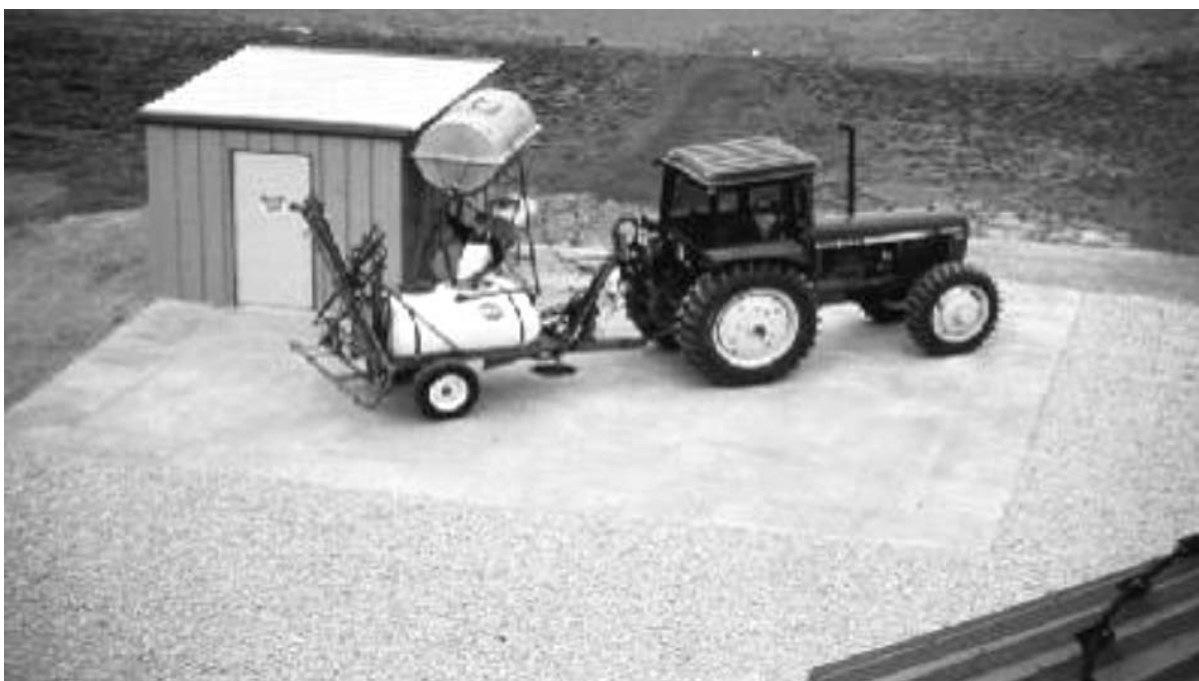
Figura 14.1. Centro de cargas de equipos pulverizadores
