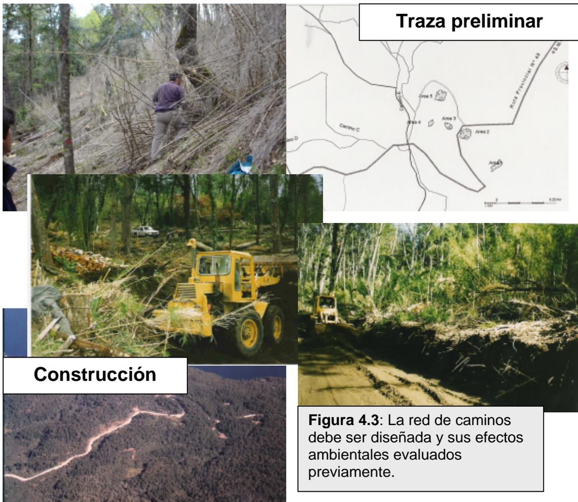
Se vuelca el levantamiento en el plano topográfico y se vuelve a analizar su traza respecto del aprovechamiento que se llevará a cabo, la ubicación de los acanchaderos y la disposición tentativa de las vías de saca.
