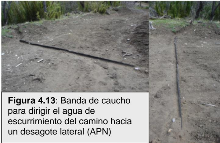
**Figura 4.13:** Banda de caucho para dirigir el agua de escurrimiento del camino hacia un desagote lateral (APN)
