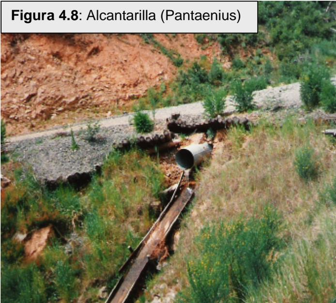
**Alcantarillas** Se utilizarán troncos huecos, tablonés y tirantes, tubos de cemento vibro-comprimidos y sólo si es necesario, chapa gruesa galvanizada corrugada y abulonada, con ó sin cabezaleros de madera y ocasionalmente con un cabezal de hormigón o piedra cementado. El relleno sobre los tubos será como
