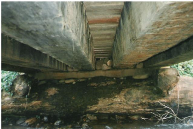
**Figura 4.11:** Vigas labradas y tablero con tablón de impacto (Pantaenius)
