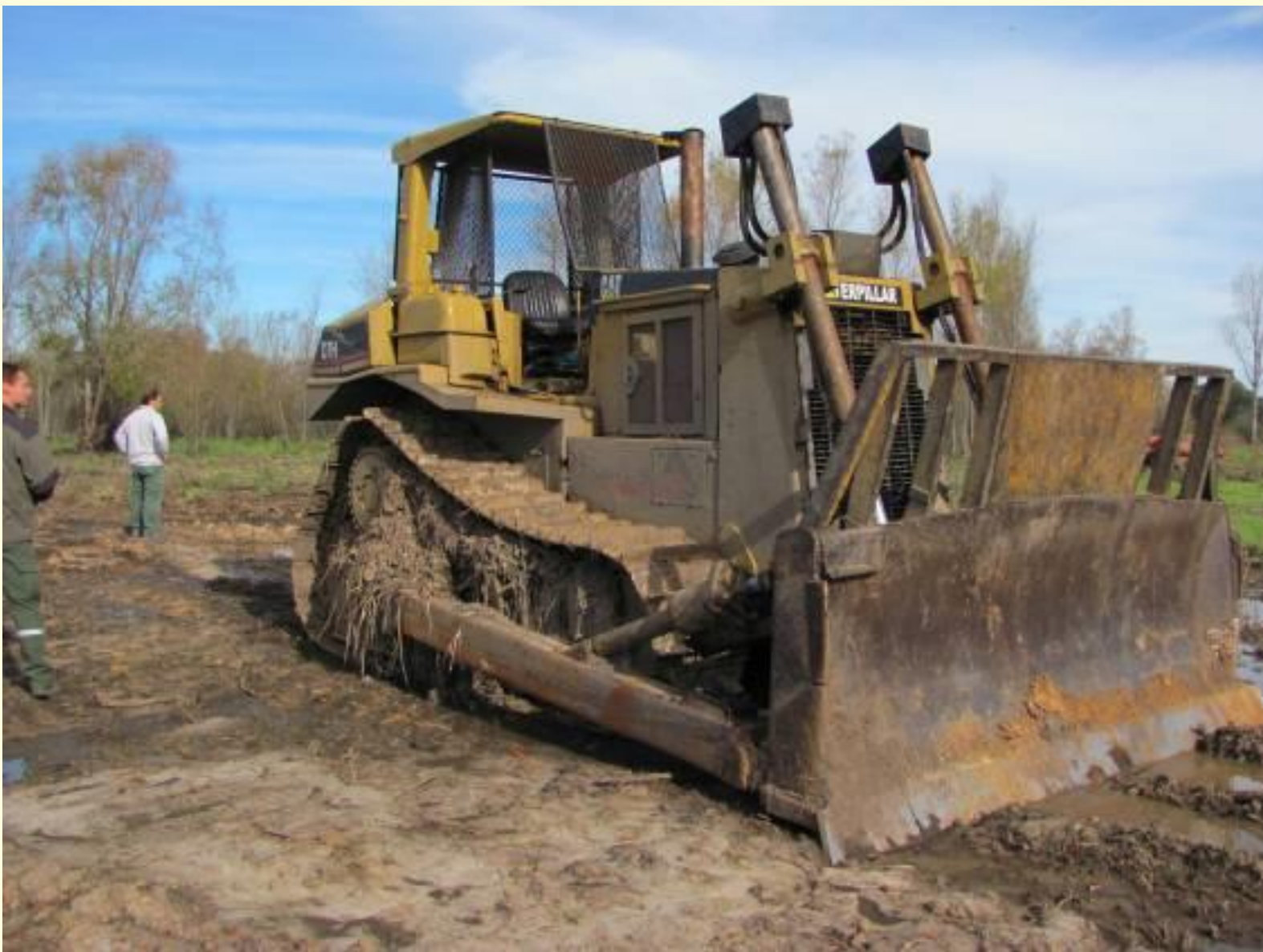
Maquinaria pesada para preparación de sitio en Delta; Estab. El Oasis APSA - topadora de orugas.
