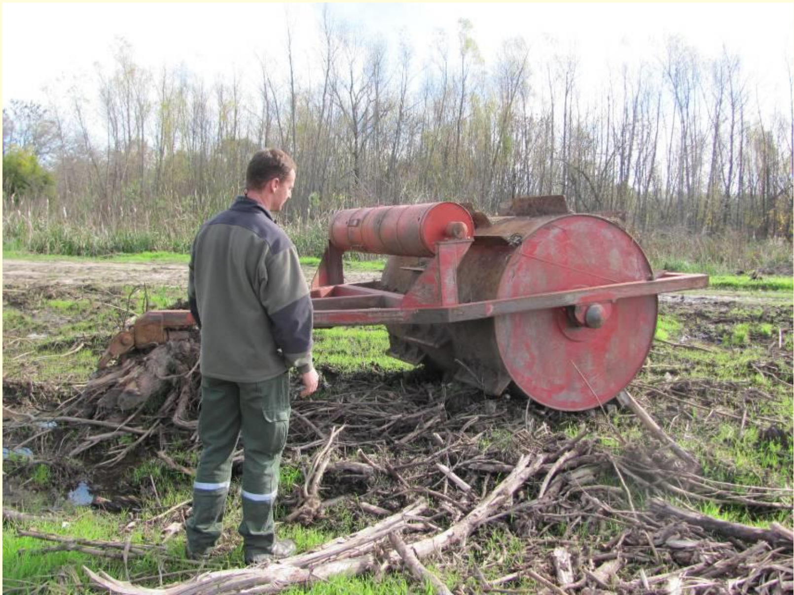
Maquinaria pesada para preparación de sitio en Delta; Estab. El Oasis APSA - rolo pesado
