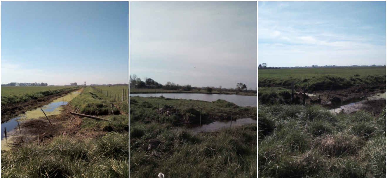
Figura 20. Obras agro-hidrológicas del establecimiento educativo salesiano en Uribelarrea. a) badén y bordo en la periferia de lote, b) cubeta de acumulación, c) intersección de badén 2º que deriva en badén 1º.
