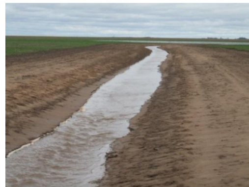
Badén simple drenando excedentes hídricos (sep. 2007).
