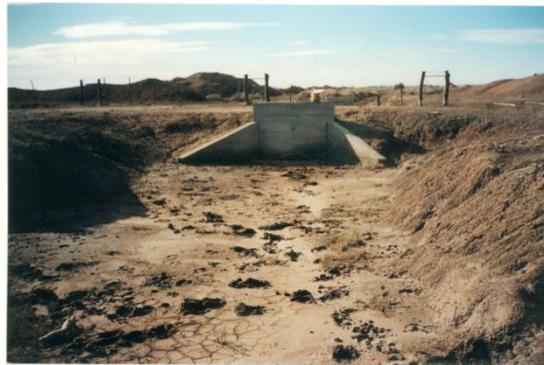
Alcantarilla totalmente obstruida en la progresiva 40 m del Ramal I-3.
